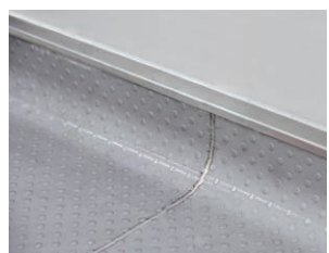
端部を50Rに折曲げた幅木を採用。ゴミ溜まりが無く、洗浄が大変容易です。
