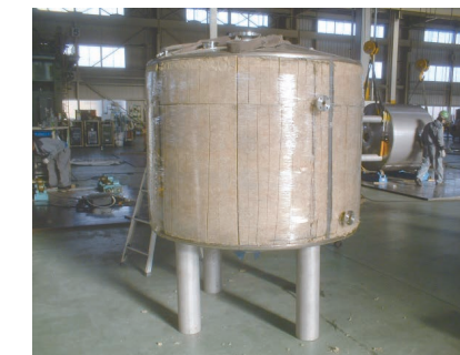
保温施工をした状態
