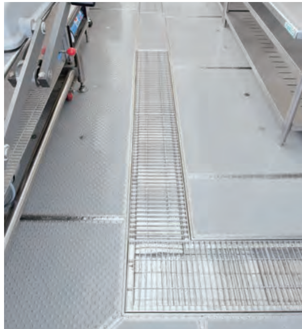
ポルカプレート、側溝施工例
